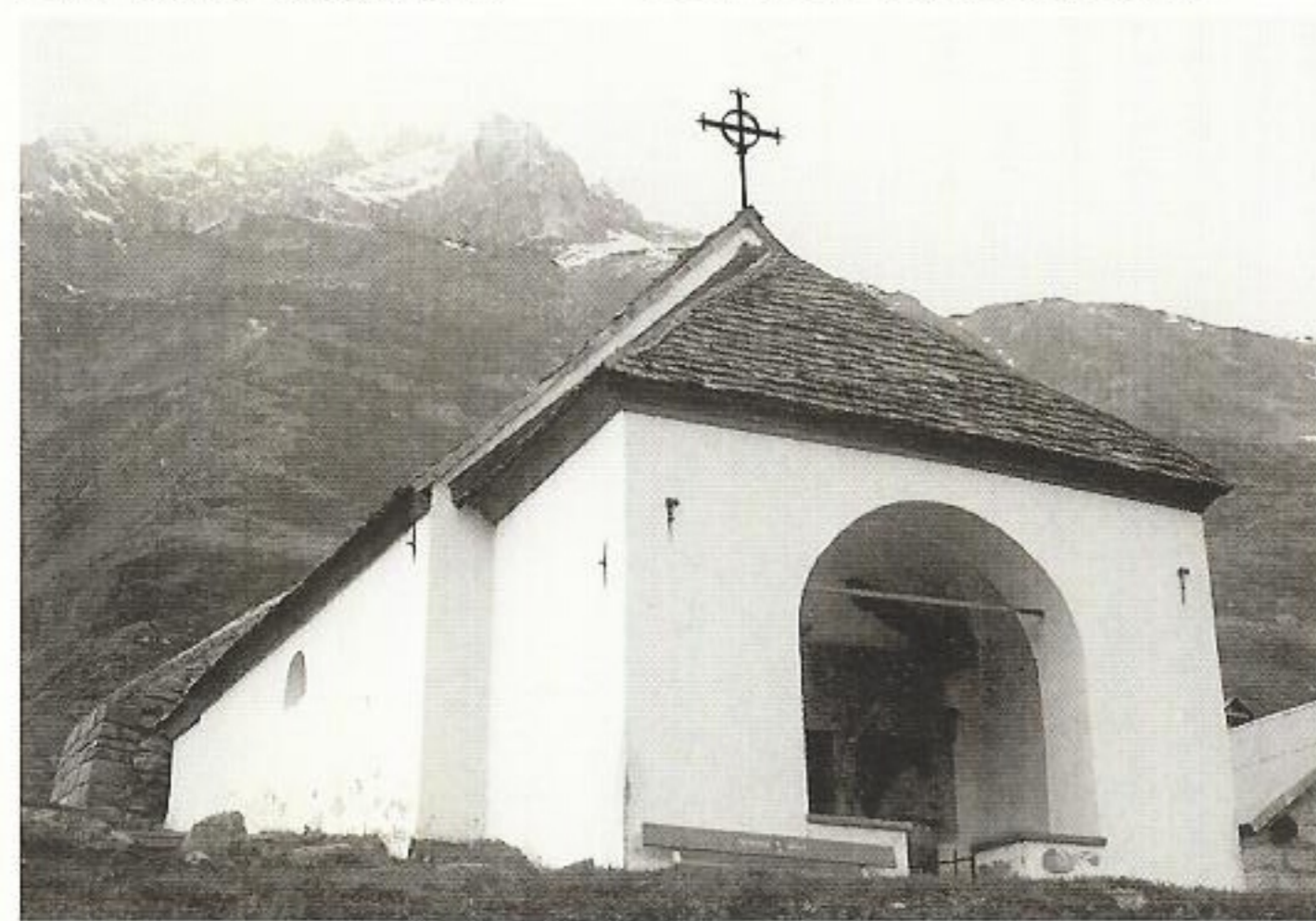
Der Turm der St.-Josefskapelle vor Realp wurde 1695 von einer Lawine weggerissen.
